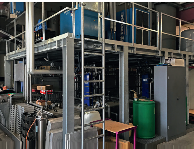
Unter dem Stahlgerüst: Waschanlage mit fünf Kammern; Erste Etage: Wärmerückgewinnung, Kompressor und Pufferspeicher (auf einem Stahlgerüst für kurze Leitungswege)
