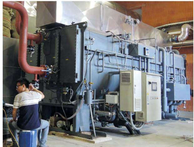
Abbildung 10: Absorptionswärmepumpe; Quelle: Wienerberger GmbH
