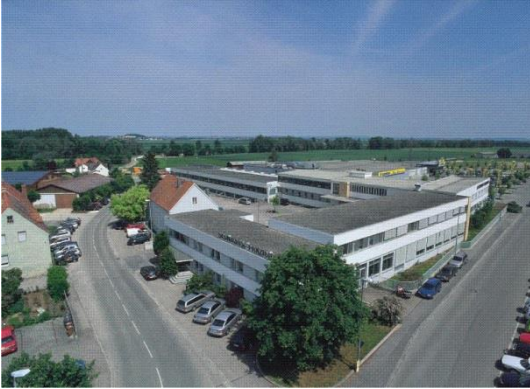
Standort Werk I Glashütter Straße 2-6
