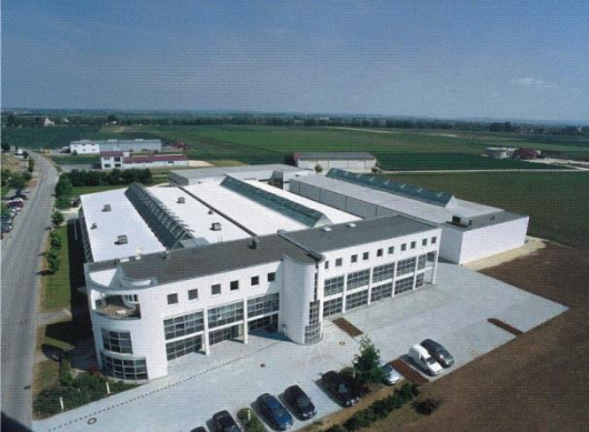
Standort Werk II Fritz-Hopf-Straße 1
