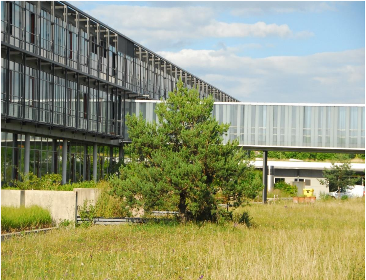
Abb. 3: Der gläserne Übergang zum neu gebauten Laborflügel des LfU wurde mit matten, nicht transparenten Glasscheiben ausgestattet und ist dadurch vogelsicher. Foto: B.-U. Rudolph
