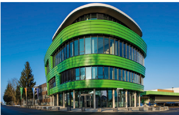
Neues Schulungszentrum am Standort Höchstädt mit energie-sparender Klimatisierung durch Grundwassernutzung.
