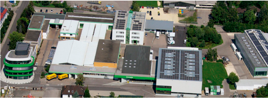
Luftaufnahme des Standorts Höchstädt, gut zu sehen ist die im Sommer 2013 in Betrieb gegangene Photovoltaik-Anlage
