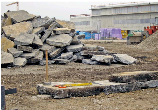
Abbruchplatten aus Beton werden zu neuen Trockenmauern aufgebaut
