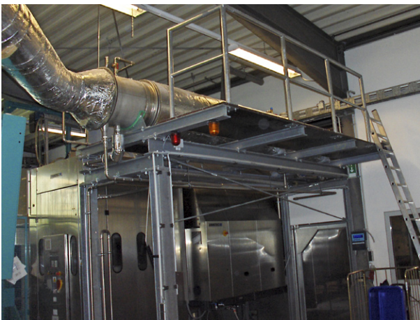
Der Wärmetauscher auf der Mangelanlage liefert unter anderem die komplette Energie für die Fußbodenheizung.
