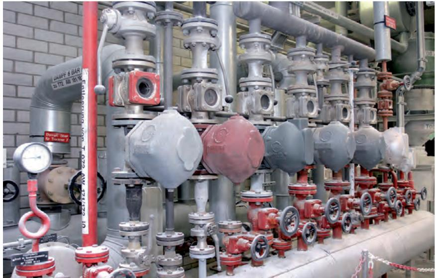
In der Kondensatsammelstelle wird das anfallende heiße Kondensat in Tanks aufgefangen. Die thermische Energie des Kondensats lässt sich mit Hilfe von Wärmetauschern fast vollständig nutzen.
