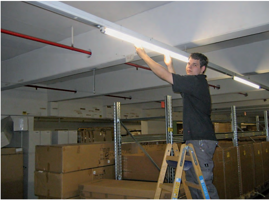
Baur-Techniker baut überflüssige Leuchten aus.
