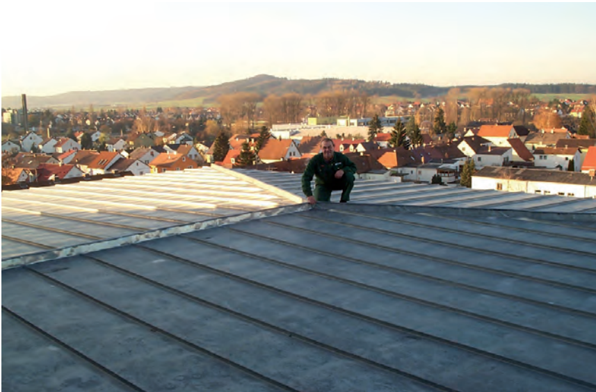
Die Regenwasser-Sammelfläche – das Dach der Brauerei
