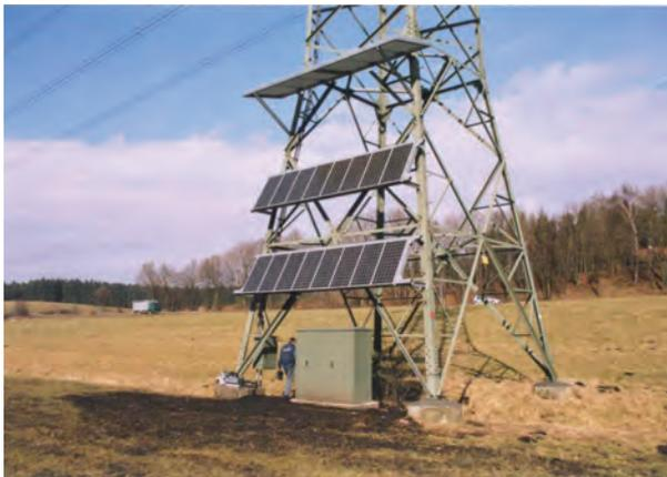
Mobilfunksender mit Solaranlage
