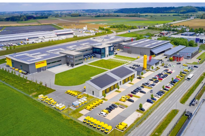
Die „Green Factory“ der Alois Müller GmbH in Ungerhausen.
