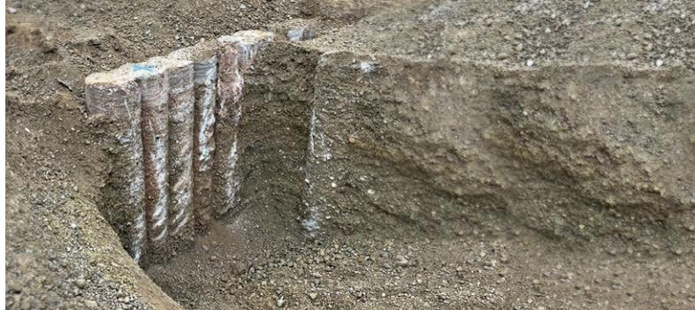
Fertige Pfehlwand aus R-Beton mit 100 % rezyklierter Gesteinskörnung
