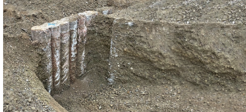
Fertige Pfahlwand aus R-Beton mit 100 % rezyklierter Gesteinskörnung
