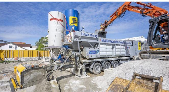
Mobile Betonmischanlage zur Baustoffaufbereitung vor Ort
