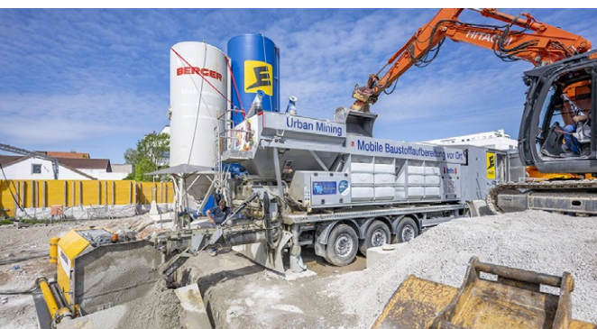
Mobile Betonmischanlage zur Baustoffaufbereitung vor Ort
